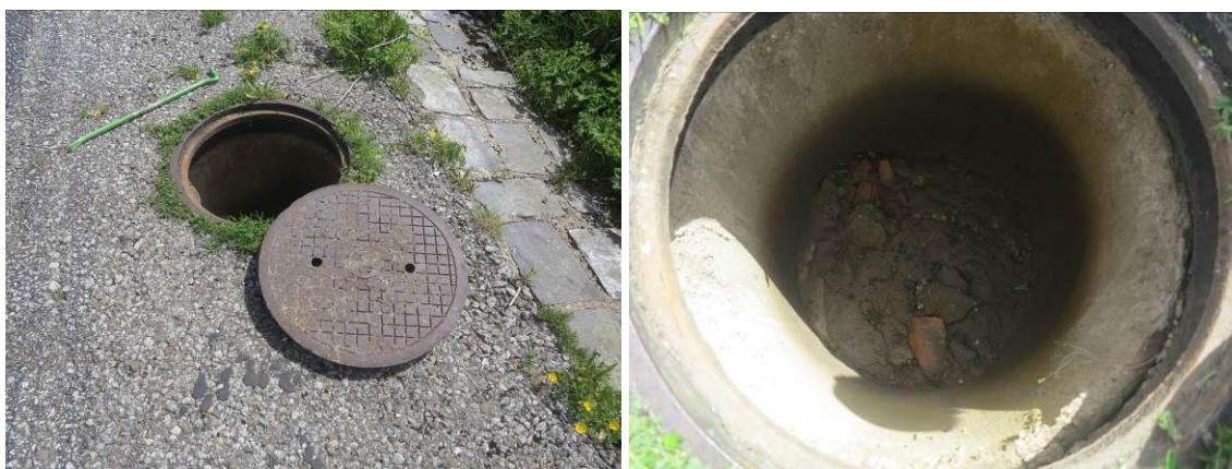
Obr.č.9. Pohľad na kontrolné šachty plytkej drenáže.
