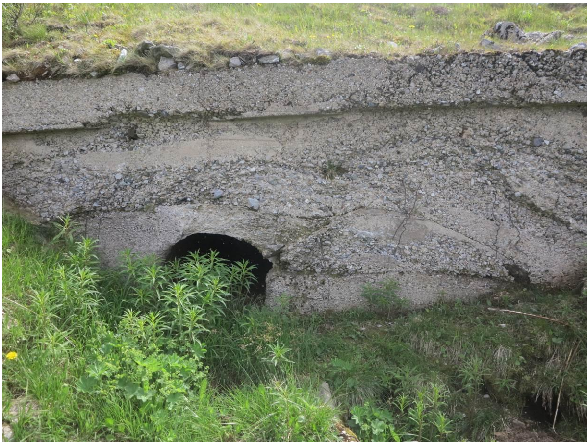
Obr č.13. Pohľad na výtokové čelo rúrového priepustu DN 800 so zvetralým betónovým povrchom.
