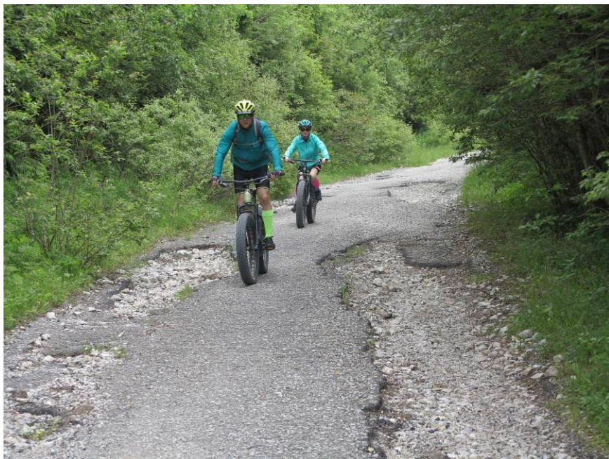
Obr. č.7. Pohľad na poškodenú asfaltovú vozovku typu B v havarijnom stave .
