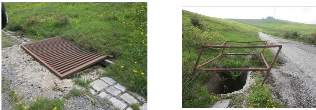
Obr. č.12. Oceľový rošt nad kalovou jamou bude na všetkých kalových jamách bez zábradlia.
