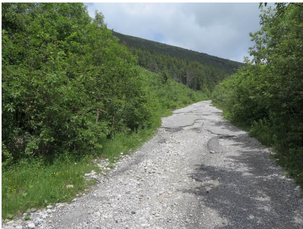
Obr. č.1. Pohľad na deštrukciu vozovky vo forme rýhovej erózie.
