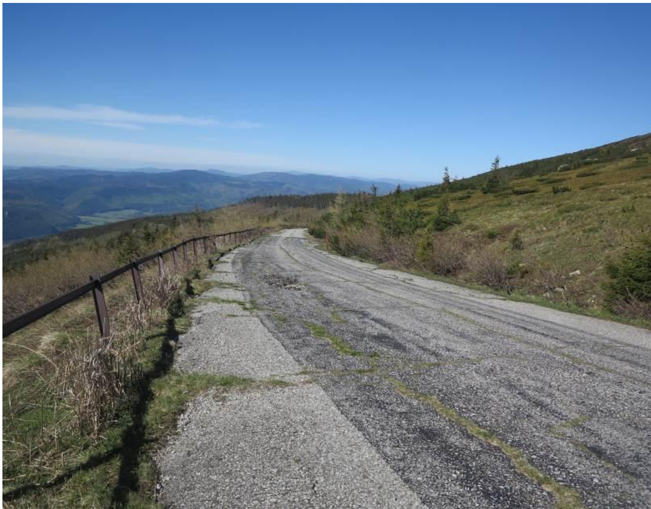
Obr. č.6. Pohľad na miernejšie poškodenú asfaltovú vozovku typu A.
