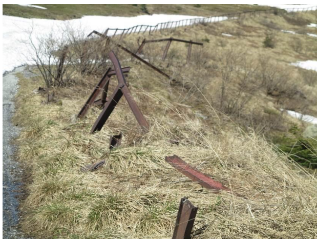
Obr. č.17. Pohľad na poškodené oceľové zábradlie výšky 1,1m
