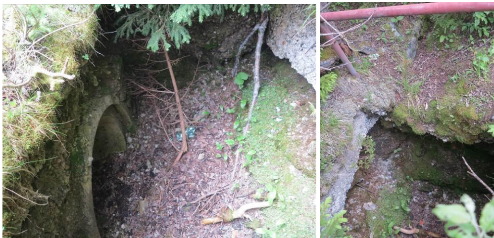
Obr. č.11. Poškodené steny kalovej jamy
